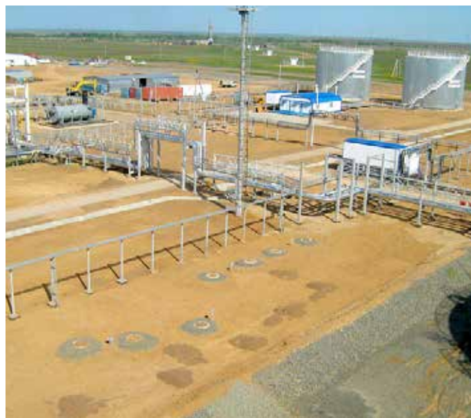
Рис. 5. Установка комплексной подготовки газа (УКПГ и УППГ) месторождения Чинаревское
